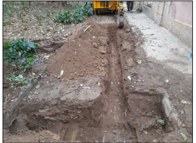
Foto 6. Obertura de la rasa 1000.
