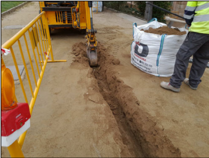
Foto 9. Obertura de la rasa 1000.
